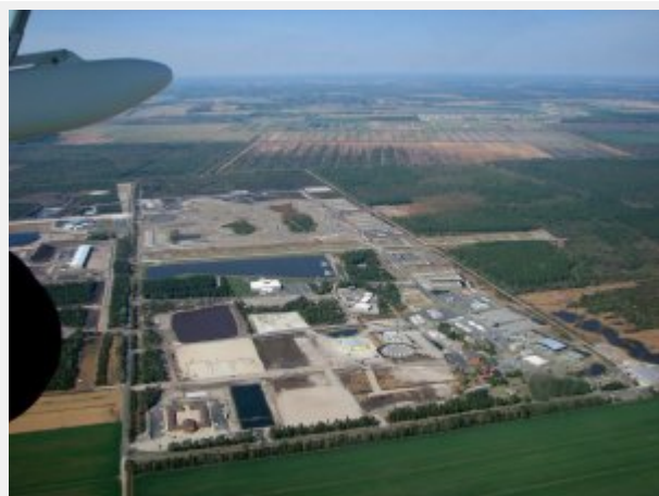
Instalaciones de ACADEMI en Moyock (North Carolina, EE.UU.)
